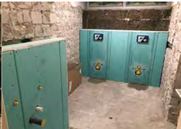
WC-Anlage im Werden
